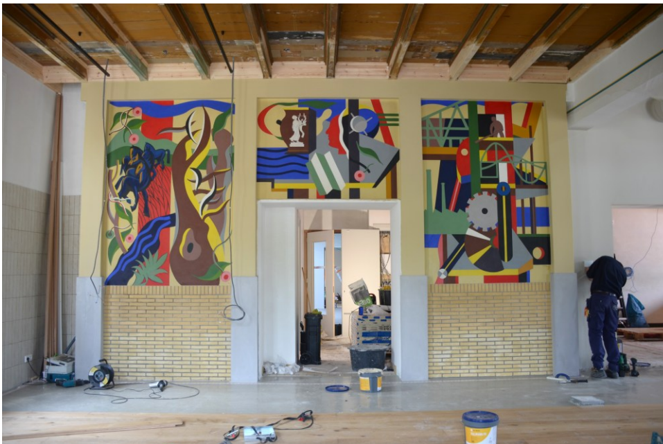
Foto: herstelwerkzaamheden muurschildering
